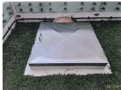
ถังเก็บน้ำสำรองเพื่ออุปโภค-บริโภคชั้นดาดฟ้า
