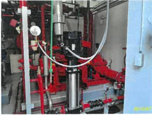
ปั๊ม และถังเก็บน้ำสำรองดับเพลิงชั้นใต้ดิน
